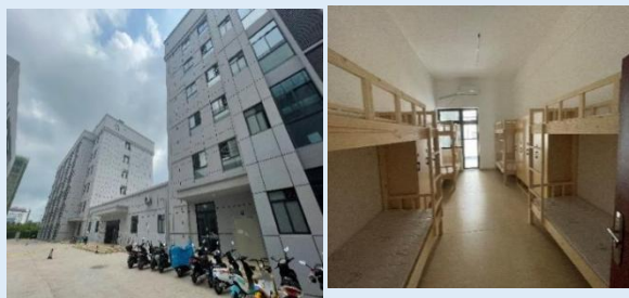
国人科技产业园—南宁市邕宁区员工宿舍实景图
