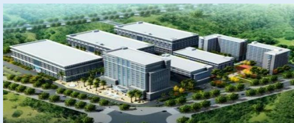
国人科技园（生产一部）深圳市坪山区
